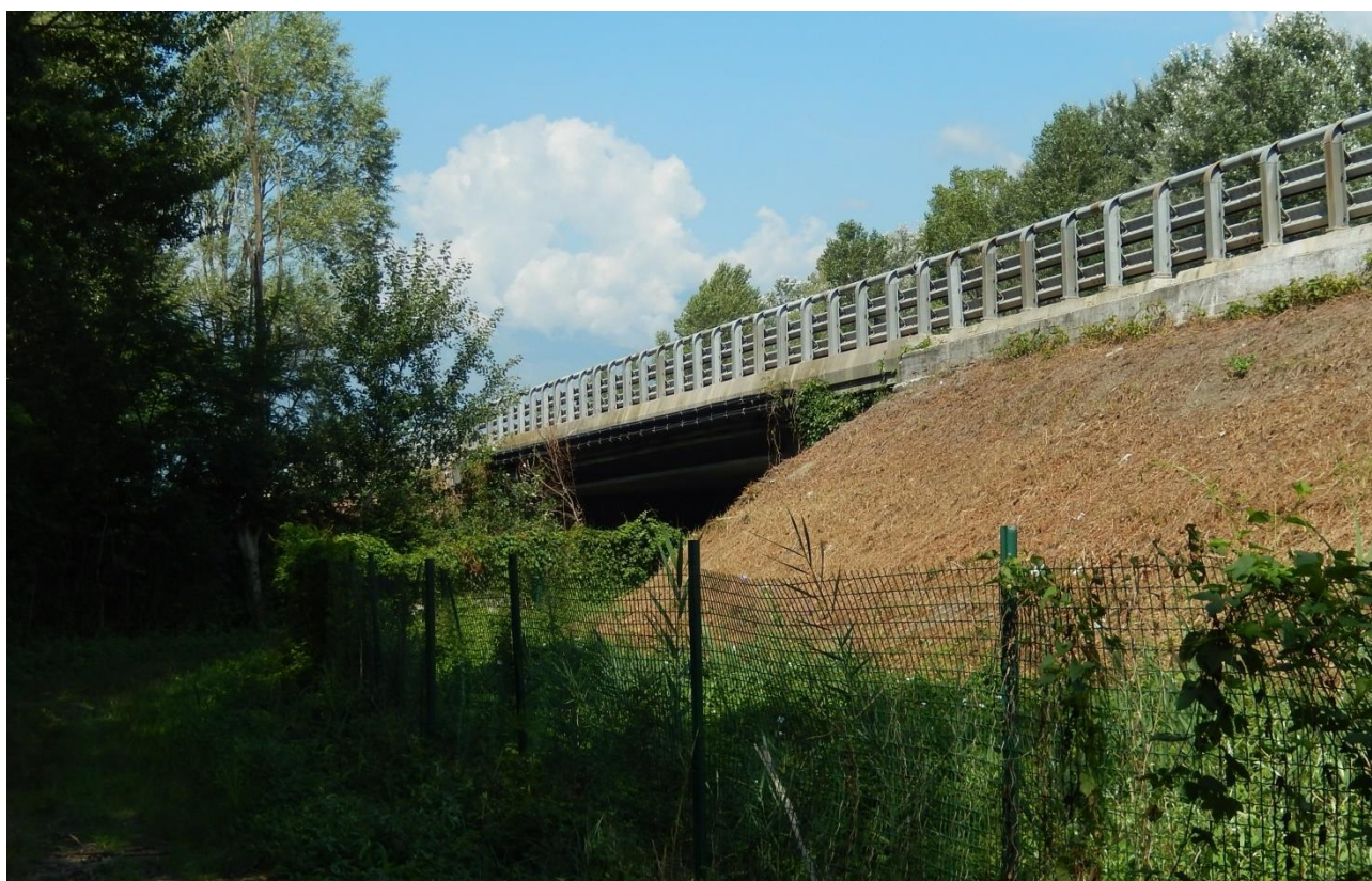
Figura 28 – Ponte di attraversamento del canale di scarico del NIE. Ripresa da est
