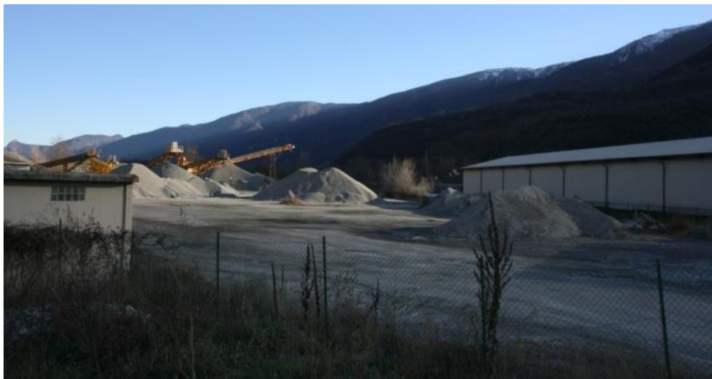
Figura 12 - Attività di trattamento inerti limitrofa all'area di intervento
